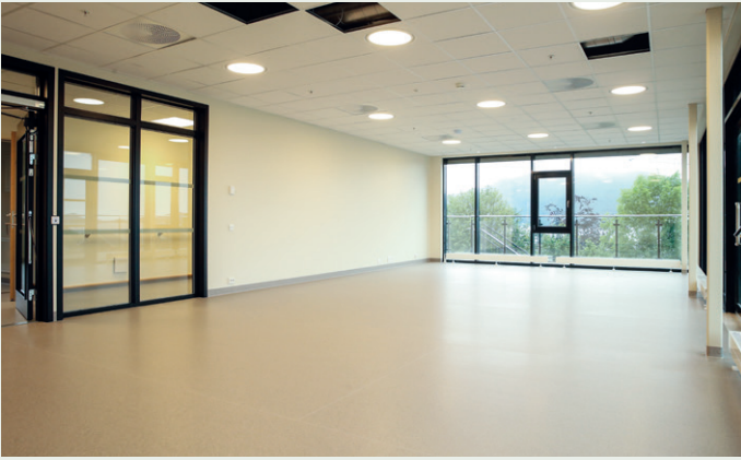
Fellesarealet i sørvestlige hjørne har vinylbelegg på gulv, sparklet og malt gips på vegger og systemhimling.
